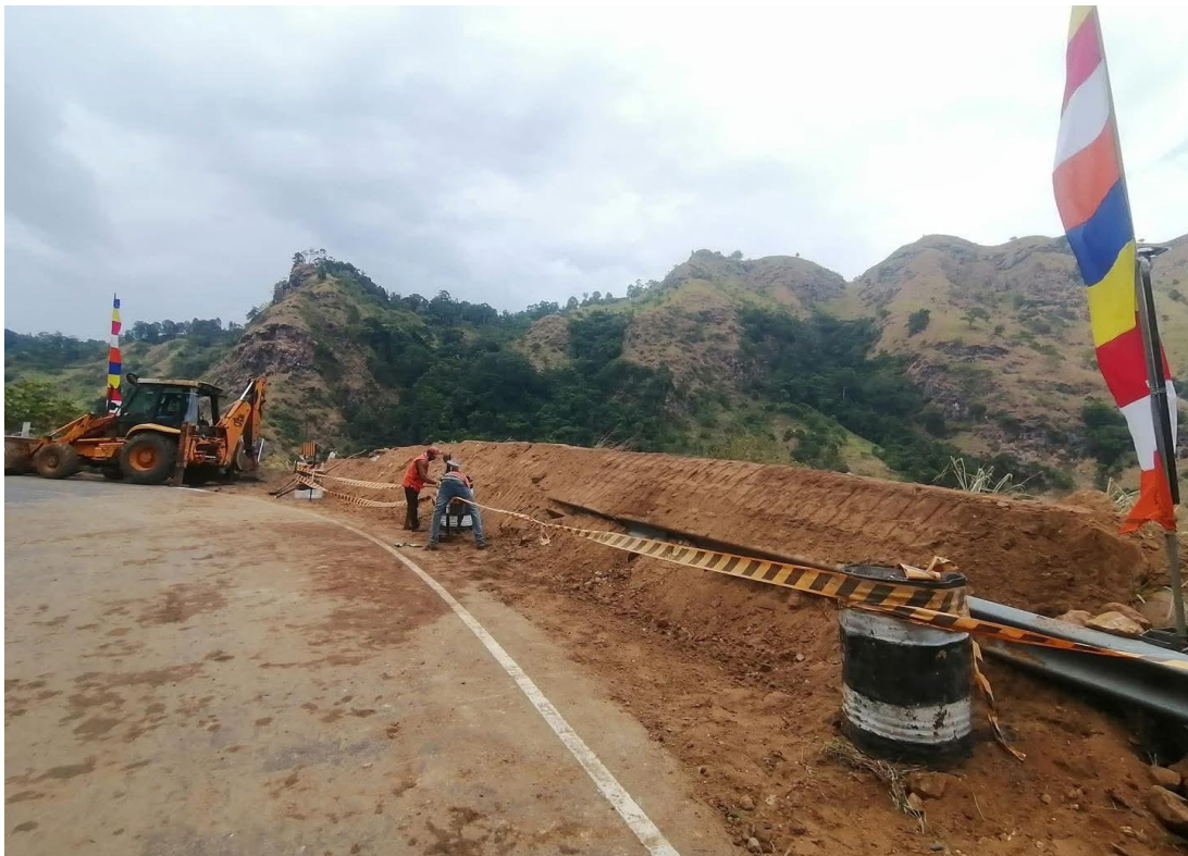
අනතුර සිදුවී දින කීපයකට පසු ආරක්ෂිත පස් කණ්ඩියක් යොදා ඇති ඇල්ල වැල්ලවාය මාර්ගය
